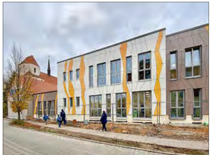
Das neue Gebäude von der Straße aus gesehen.
